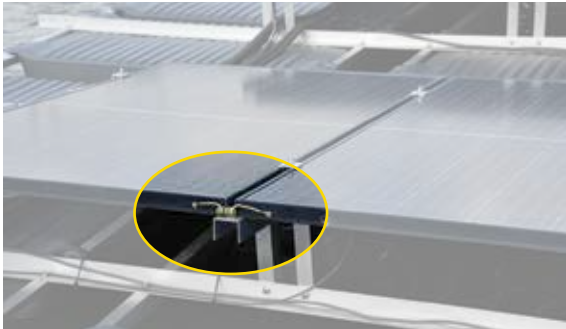
FIGURE 8.3 Equipotential bonding conductor
